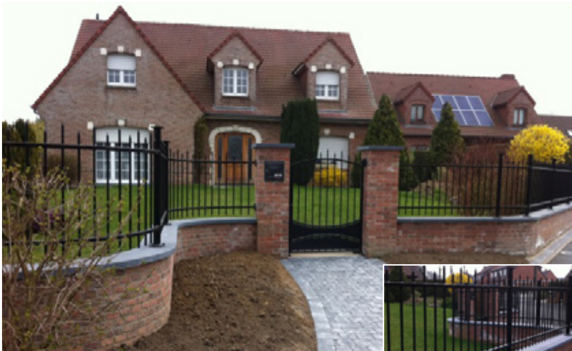
Réalisation portail, portillon et clôture.
